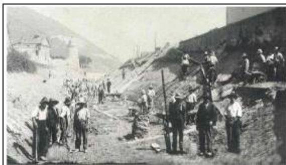
Lavori scavo Canale Bisatto – foto storica
